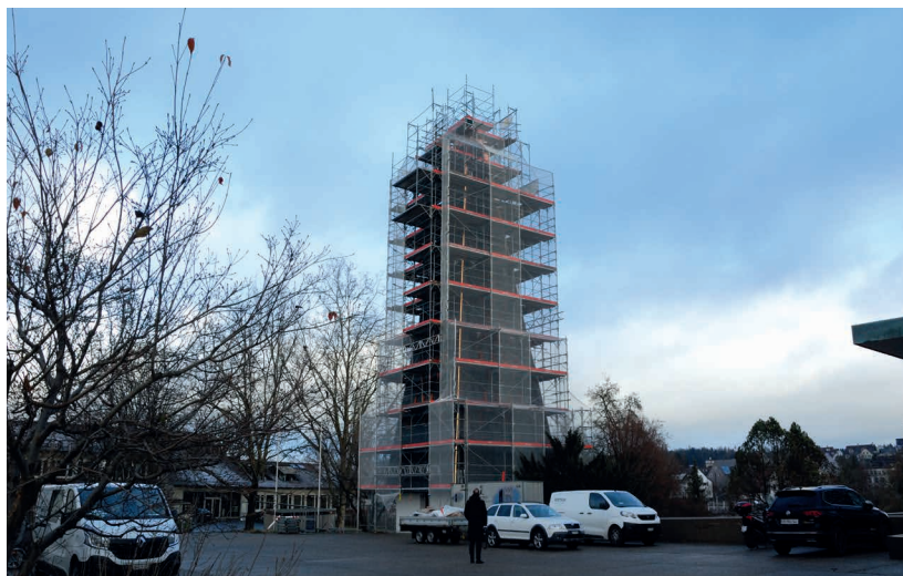
Renovationsarbeiten am Kirchturm
