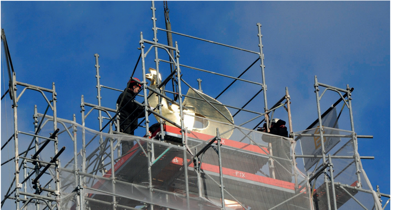
Montage vom neuen Güggel auf den Kirchturm am 7. Dezember 2021
