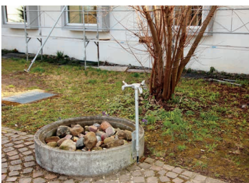
Vor der Sanierung, 2013
